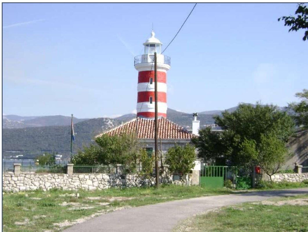
Svjetionik na rtu Oštru
